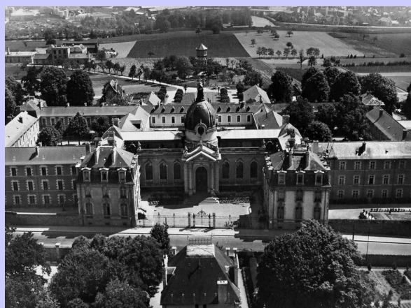
Les bâtiments avant 1939. L'établissement ne s'est pas encore étendu vers le sud.
